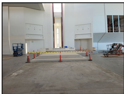
View of Altar from Nave. Vista del Altar desde la Nave.
