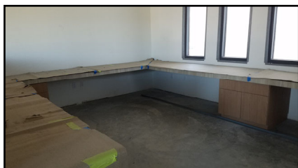
Volunteers' work area. Área de trabajo de voluntaries.
