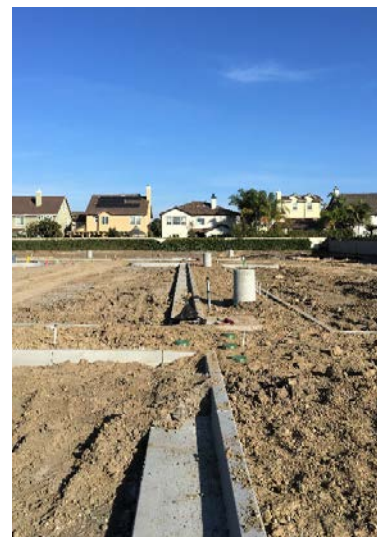
Bordillos de estacionamiento y jardineras
