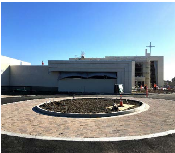
Cambio de tráfico frente al instalación parroquial
