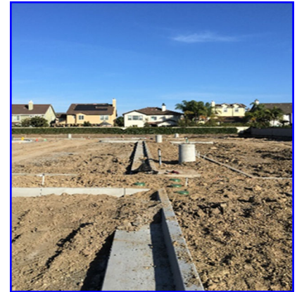
Vệ đường và bồn trồng cây cỏ
