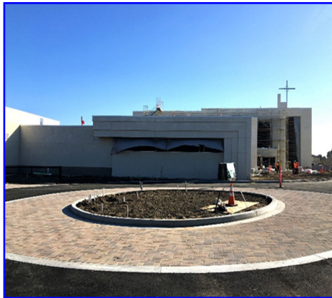
Cambio de tráfico frente al instalación parroquial
