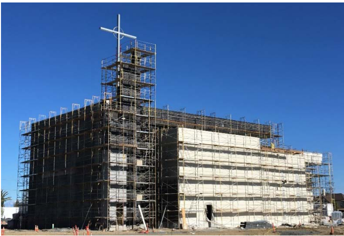
Se enyesa el muro sur de la Iglesia
