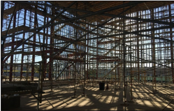
Cột giàn xây dựng bên trong Nhà thờ
