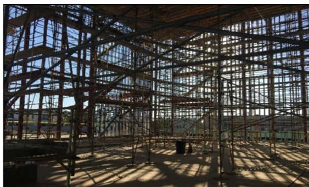
Andamios dentro de la Iglesia
