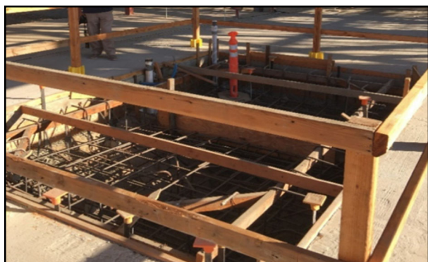
La piscina bautismal y la fuente empotrada en la entrada
