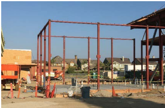
La Sacristía de la Iglesia está ahora enmarcada
