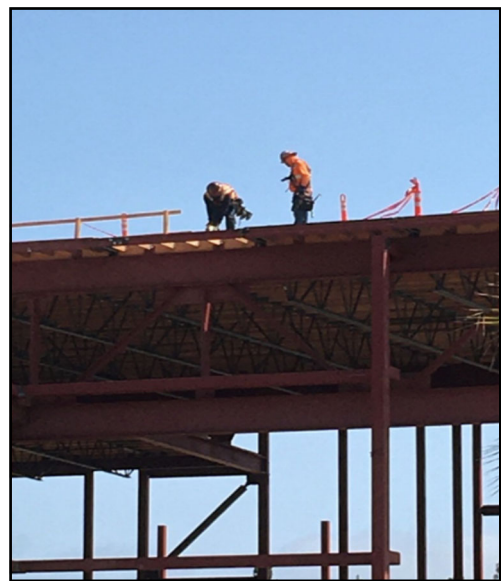
Equipos de construcción trabajando a grandes alturas
