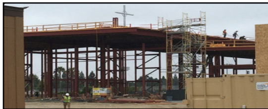
Thợ đang xây mái cho Nhà thờ mới
