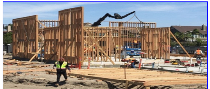
Se empezó la estructura del centro parroquial...
